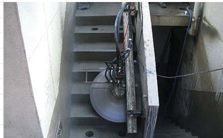
ウォールソーによる解体(右2点も)。
