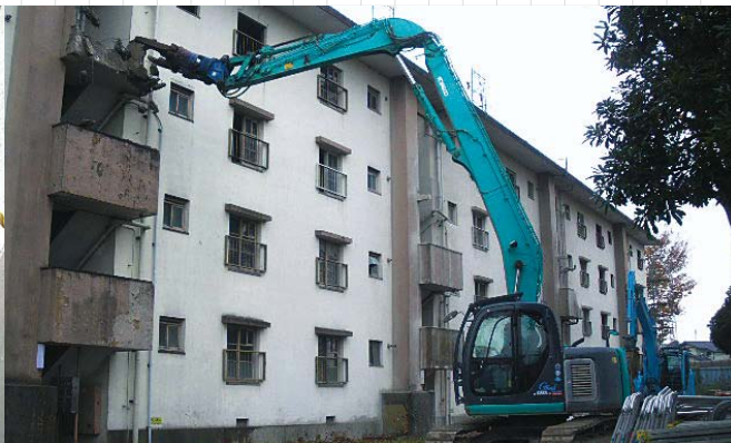
解体用ニブラー(重機)。工事期間は短縮できる。
