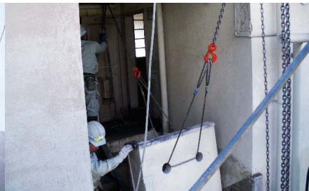
解体材の撤去は人力とレッカー(重機)で。
