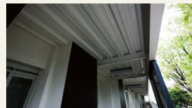
鉄骨柱デッキ合成スラブの外廊下。
