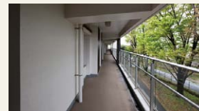
RC片持ち梁の外廊下。
