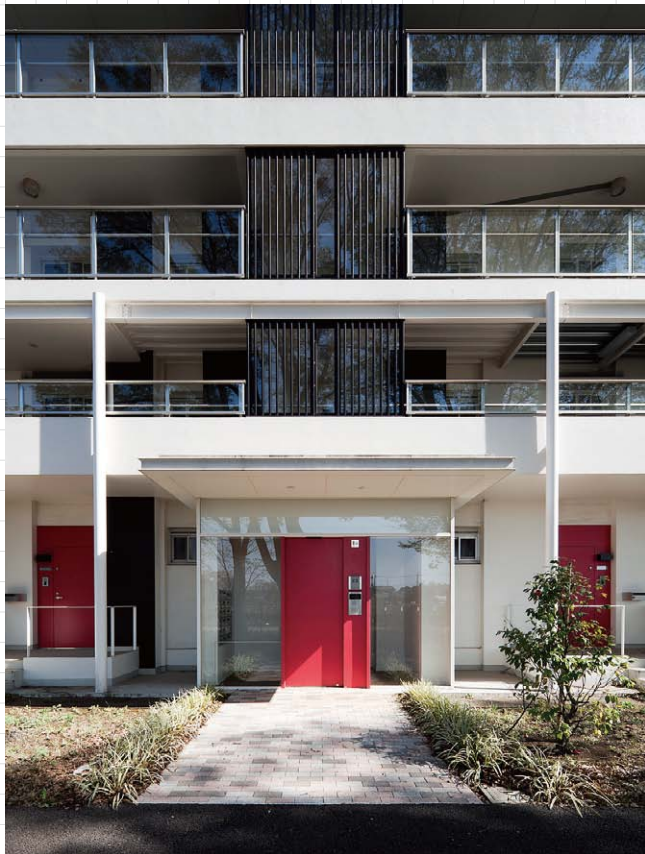
階段室を解体撤去してエレベータと外廊下が設置された(A棟)。
