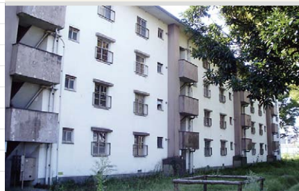
階段室側外観
