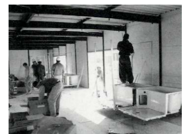
ユニットバスルームの現地への搬入
