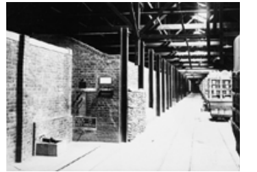
重油焼成に改造したドレスラー式トンネル窯第3号
