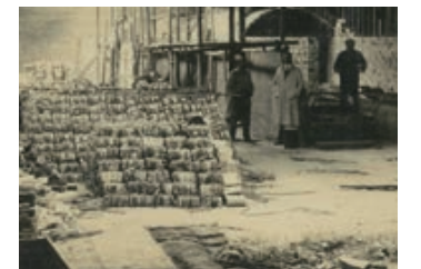
トンネル窯の築造工事風景(1919年)
