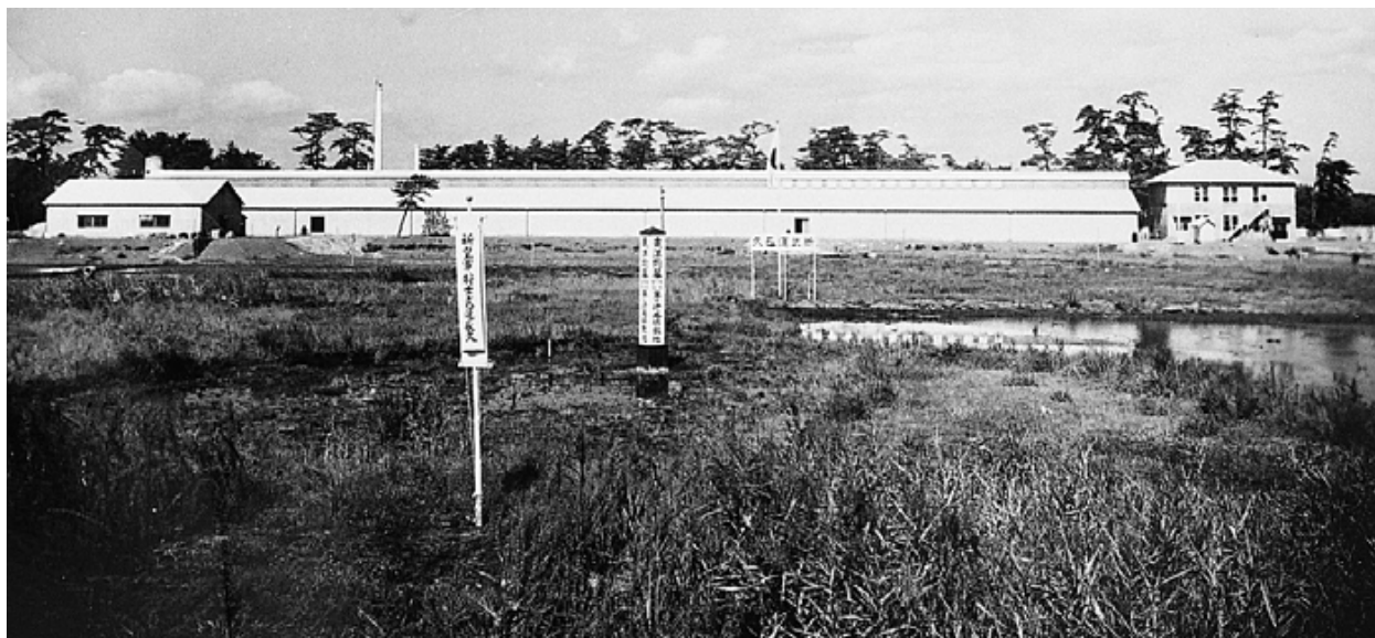
茅ヶ崎工場(第1期工事)が完成(1937年) 東京をはじめ関東地方以北の市場を対象とした拠点。
