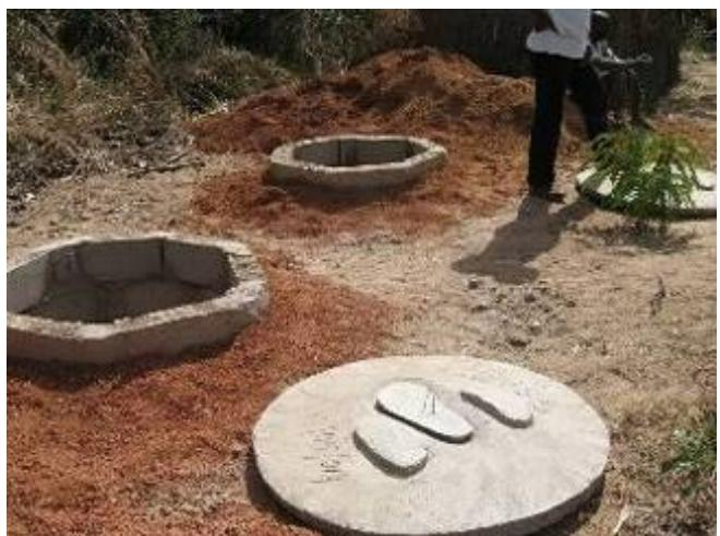
(左)便器を乗せれば完了する2基。(下)ブロックを設置する作業を行う2基。合計4基を制作。
