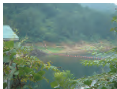
栈橋設置予定の山王海ダム
