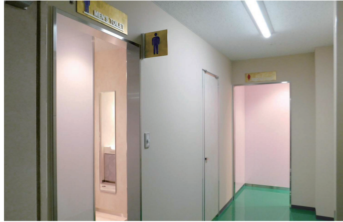
B2棟 3F北東 トイレ入口
