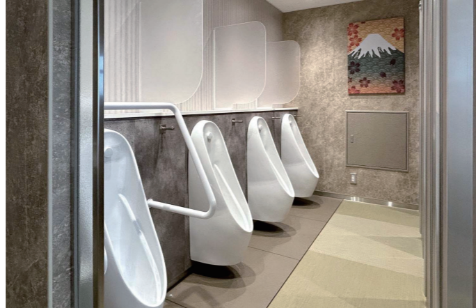
B1棟 2F東 男性トイレ 小便器コーナー
