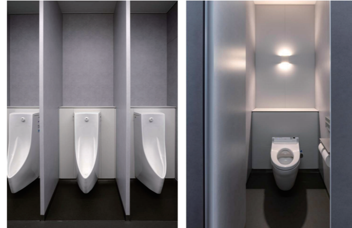
オフィスフロア 男性トイレ 小便器・大便器コーナー
