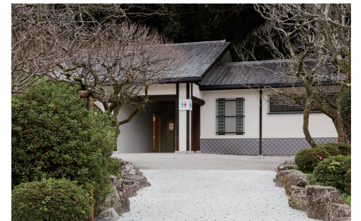
照星館横トイレ 外観
